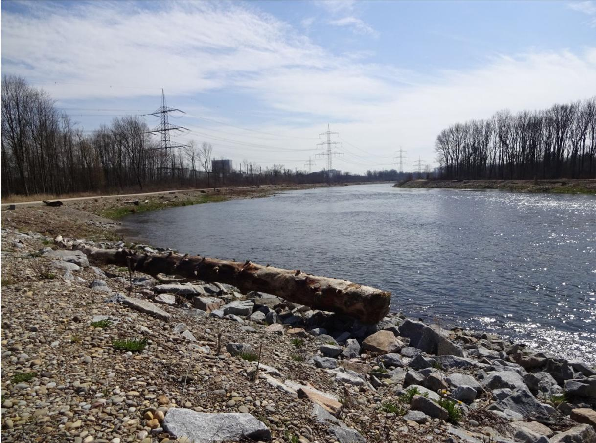
*Abb. 2: Iller bei Vöhringen: jüngst renaturierter Gewässerabschnitt mit aufgeweitetem Profil und offenem Deckwerk*
