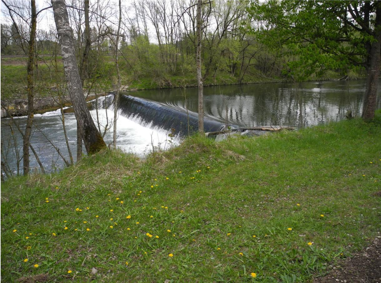
*Abb. 2: Iller bei Pleß: eingetiefter Abschnitt mit Sohlschwelle*
