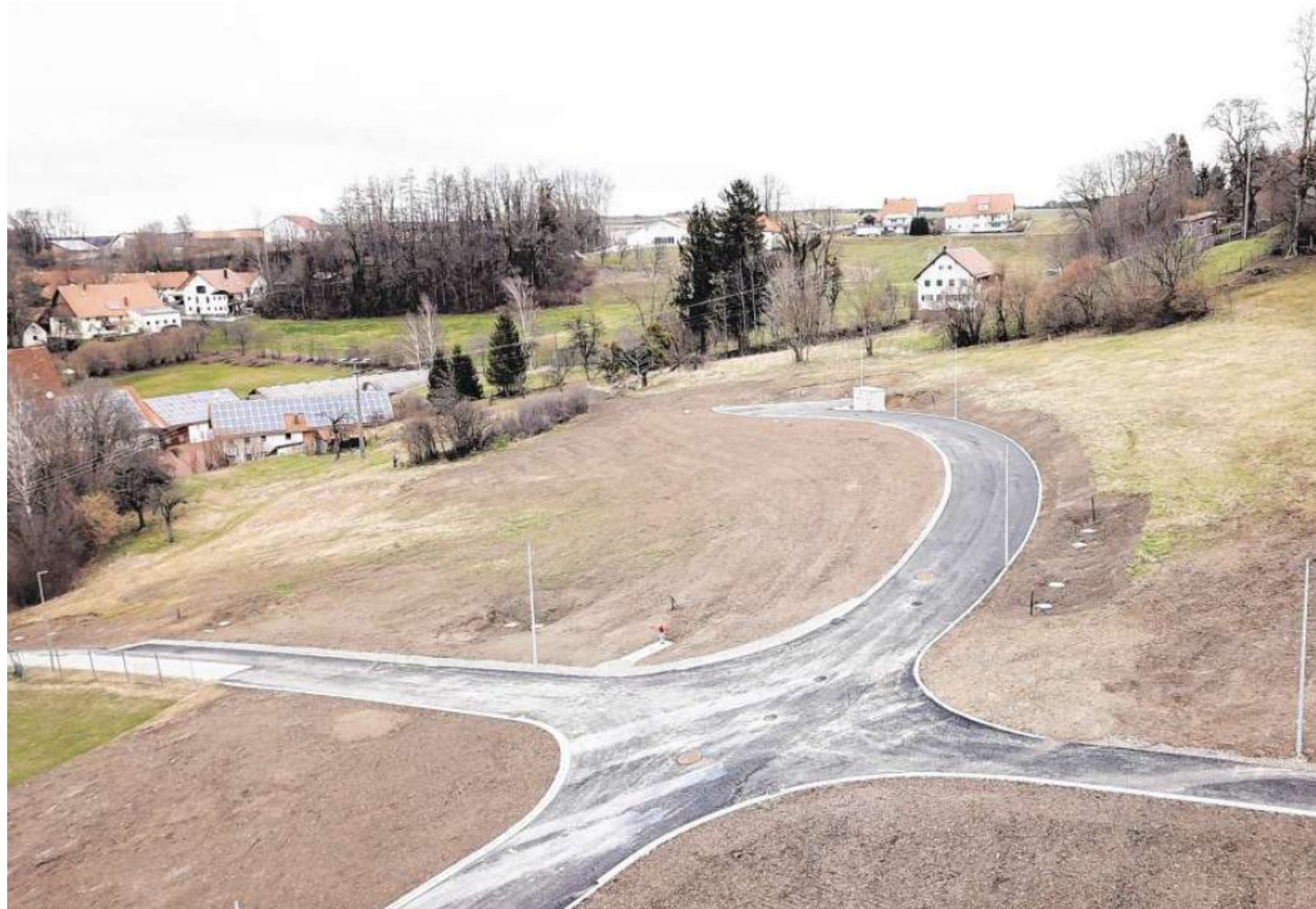
Die Erschließung des neuen Baugebiets „Osterberg“ in Frickenhausen ist weitgehend abgeschlossen.
