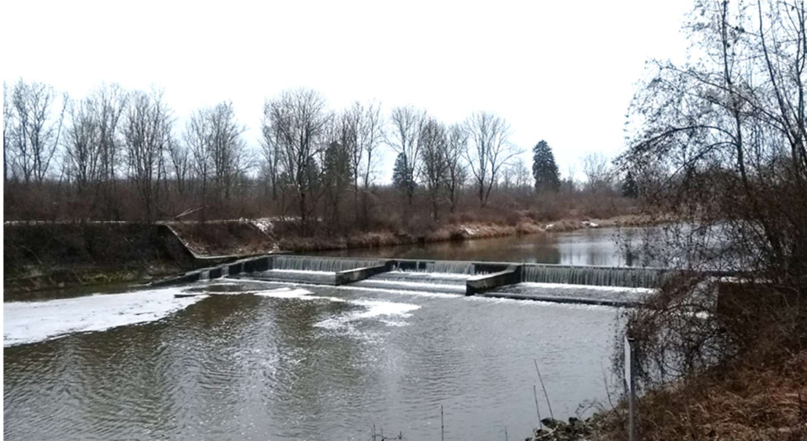
Abbildung 1: Bestehendes Querbauwerk Fkm 43, 115
