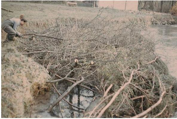
Abbildung 74: Astwerk und Reisig werden zwischen dem Pfahlraaster ausgelegt
