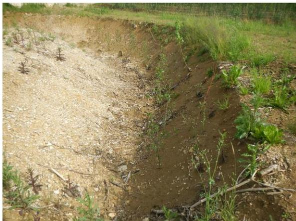
Abbildung 83: Fertiggestellte schlafende Ufersicherung mit beginnendem Aufwuchs
