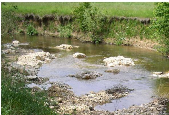
Abbildung 76: Steilufer – Abbruchkante mit morphodynamischer und vegetativer Eigenentwicklung am Kocher bei Hüttlingen. Im Vordergrund sind die Strukturbauwerke Steinbuhne mit Stummelfaschine sichtbar, in der Flussmitte Geschiebedepots aus unterschiedlichen Steinkörnungen
