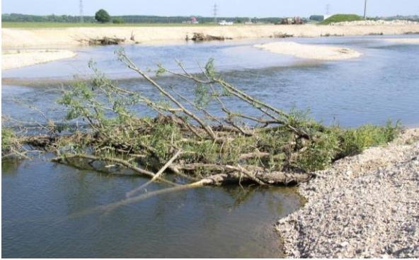
Abbildung 60: Quer zur Fließrichtung eingebaute Raubäume mit starker Bühnenwirkung und hohen Rückzugspotenzial für Fische, Donau bei Hunderingen/Binzswangen. Zusätzliche Weidensteckhölzer treiben an der Stammbasis aus
