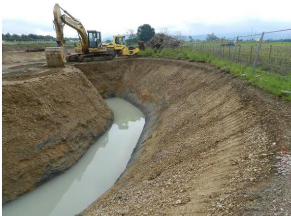
Abbildung 81: Aushub für den Einbau einer Schlafenden Sicherung
