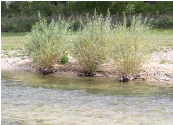
Abbildung 70: Dreiergruppe aus lebenden Faschinenbunnen mit deutlich erkennbarem, vorgelagerten Flach-/ Ruhewasserbereich in der Birs bei Birsfelden, Schweiz
