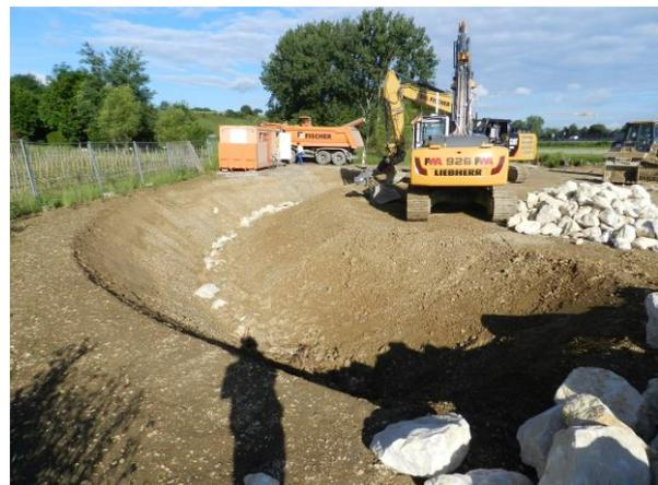
Abbildung 82: Teilweise Wiederbefüllung nach Einbau der Steine
