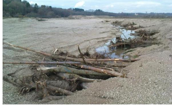
Abbildung 61: Sequenz aus 7 großen, mehrstämmigen Raubaumbühnen zur Strukturierung und Lenkung des neuen Donau-Außenbogens bei Hunderingen/Binzswangen
