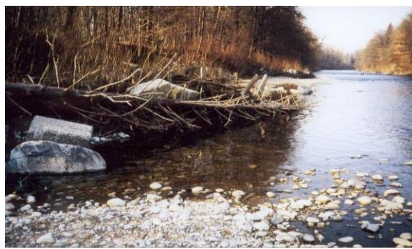
Abbildung 59: Große Raubäume in der Emme (CH), Die Bäume wurden an Pfählen stabil verankert und zusätzlich mit Blocksteinen gegen Aufschwimmen beschwert. Deutlich erkennt man die langen Kiesfelder im Strömungsschatten bis zum nächsten Bauwerk.
