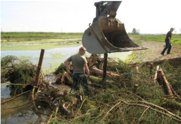
Abbildung 62: Einbau großer Raubaumbühnen, Befestigung mit Pfählen in der Donau bei Hunderingen / Binzwangen
