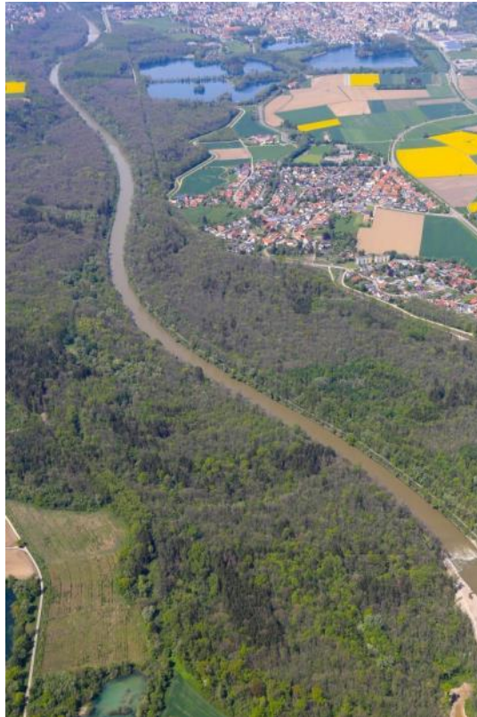
Abbildung 6: Iller Fl.km 13+600 (unten rechts im Bild) bis Fl.km 9+242 (oben links im Bild) [Quelle: Luftbild Geyer, 06.05.2014]
