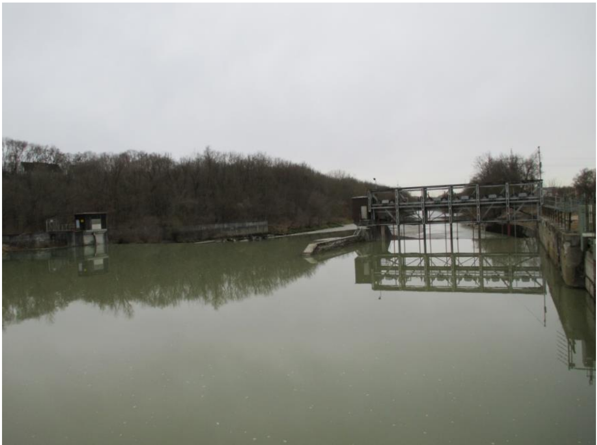
Abbildung 8: Ayer Wehr, Blickrichtung stromabwärts [Quelle: BCE, 11.02.2014]
